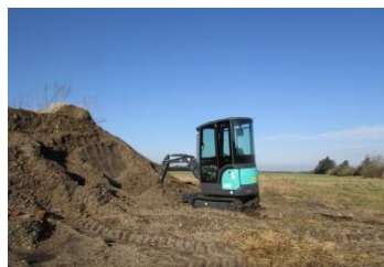
IHI 19 VXT- arbejdssituation
